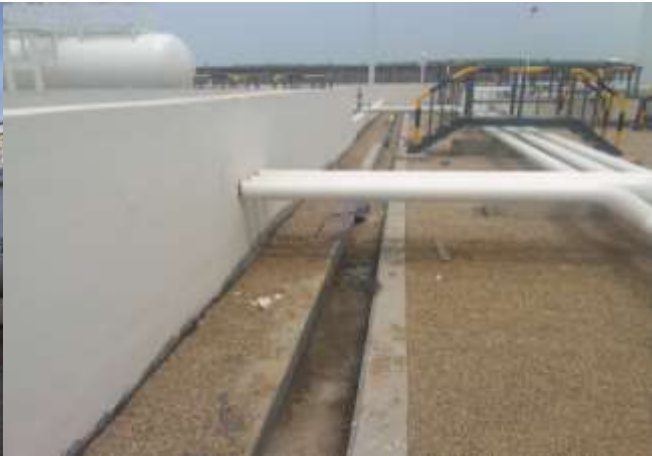
罐区内排水沟
