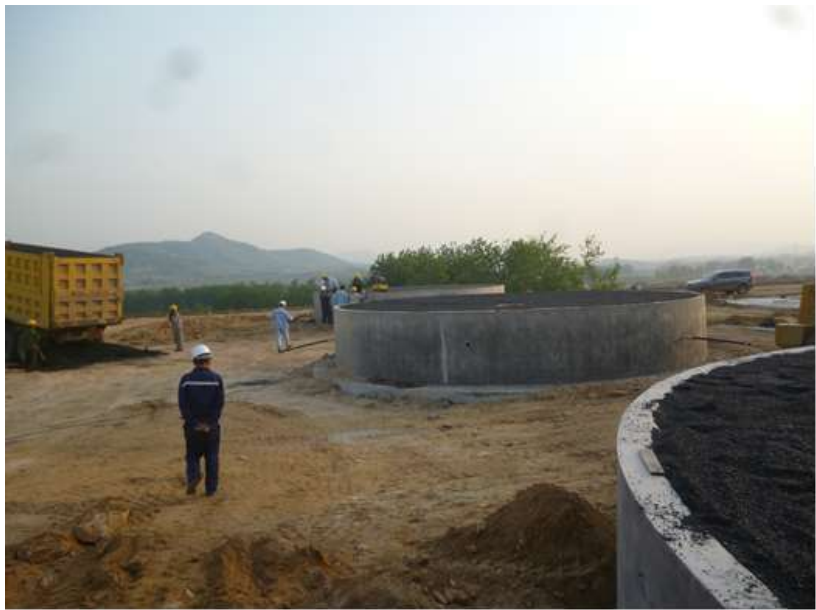
油罐区防渗施工
