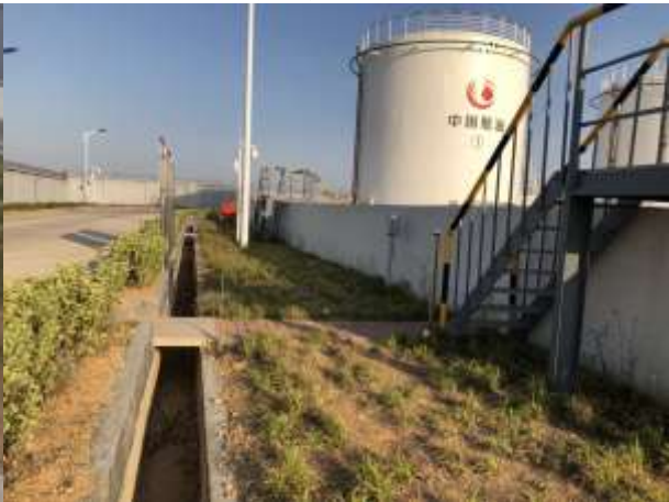
罐区外排水沟
