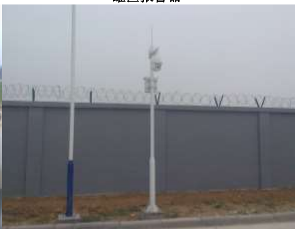
油罐区监控设备
