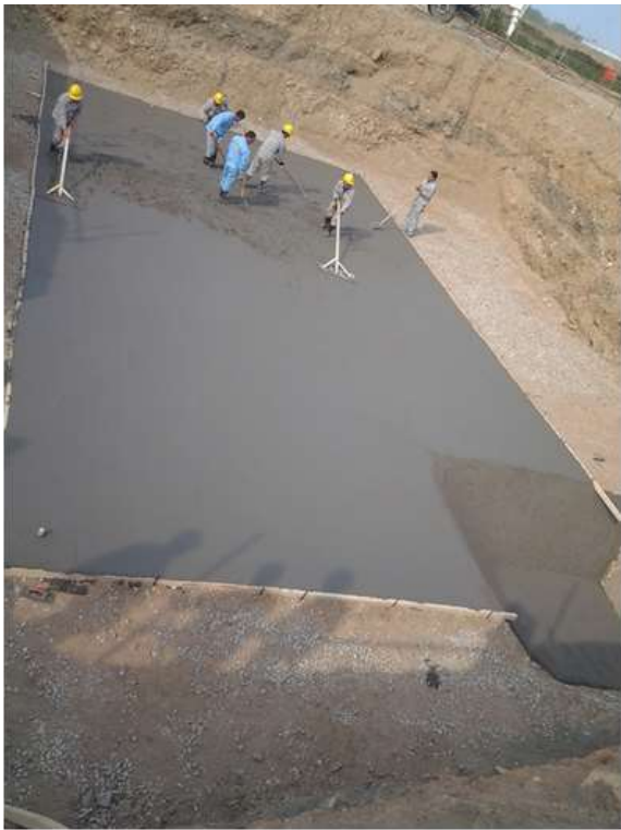
事故水池防渗施工照片
